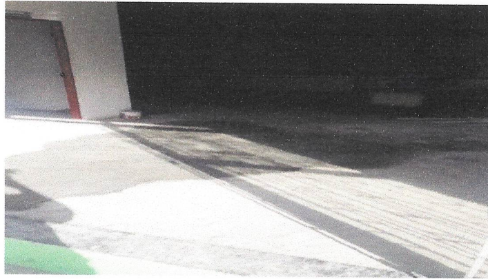
ASSENTAMENTO DE PISO CERÂMICO
